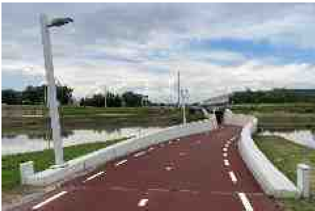
Fietstunnel op de verbinding Horst-Venlo; deze loopt onder de Greenportlane.
