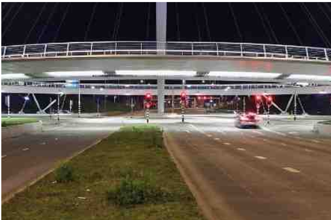
Hovenring Eindhoven-Veldhoven: fietsrotonde waar enkele belangrijke fietsroutes samenkomen. De fietsers kunnen volledig gescheiden van het autoverkeer, dat onder de rotonde rijdt, hun verdere route kiezen. In het ontwerp zijn de aanrijhellingen lang gemaakt voor fietscomfort, en is extra aandacht besteed aan verlichting en sociale veiligheid tijdens de avonduren.
